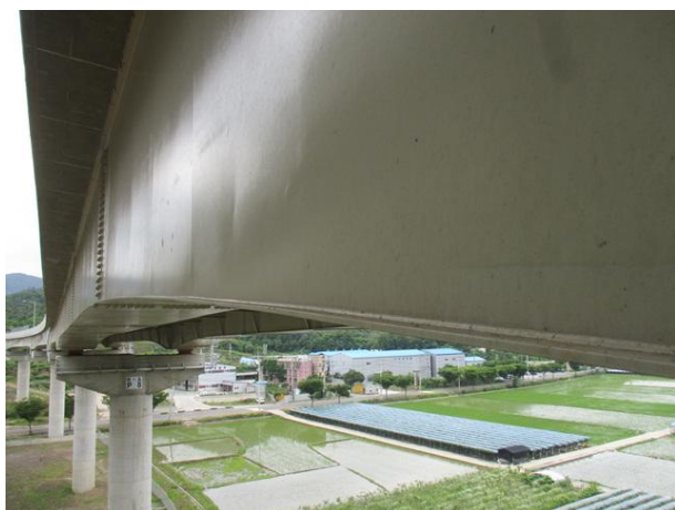
10공구 영천JCT R-A교
