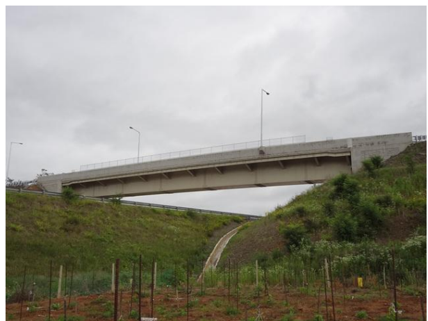
8공구 화산JCT R-A교
