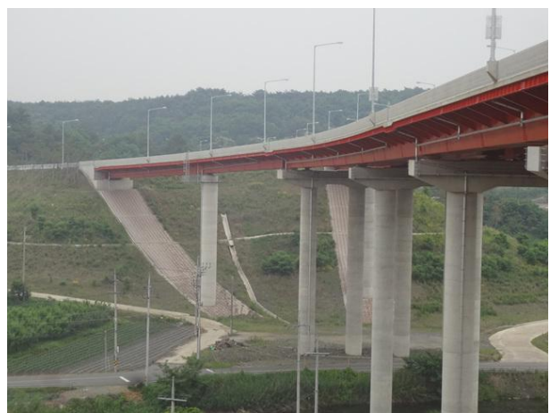
8공구 화산JCT R-H교
