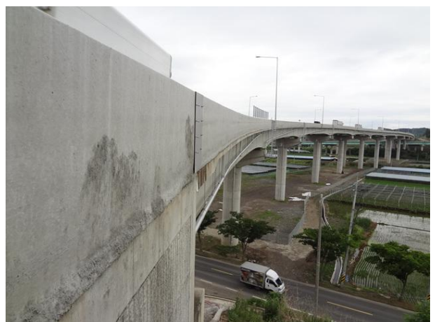
10공구 영천JCT R-B교
